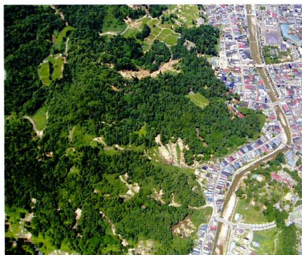
写真1 栃尾市街地周辺の丘陵部(丘陵部には多数の崩壊が発生し、溪床沿いに土砂が流下した箇所も見られる。市街地周辺を南側から撮影。)
