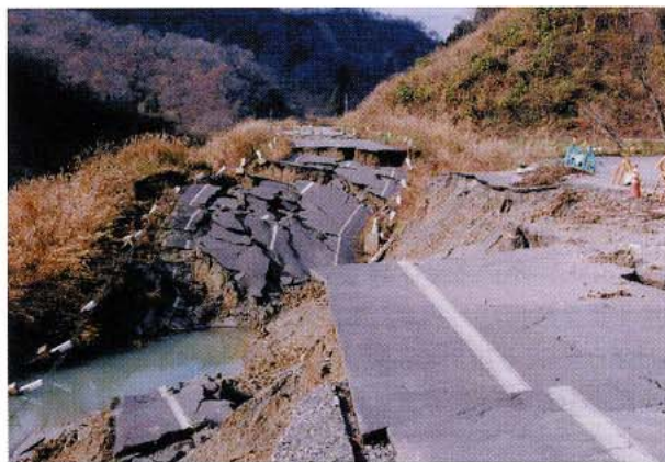
写真3 盛土崩壊の例（沢の横断部分がそっくり崩れている，長岡市（旧小国町）法末（ほうすえ）地内。）
