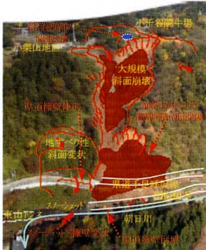
写真11 東山地区 大規模斜面崩壊状況
