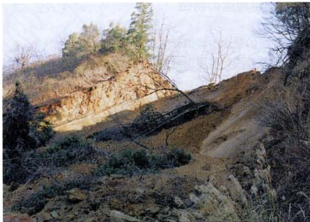
写真2 層すべりの例（約37度傾斜した砂岩泥岩互層の層理面に沿って尾根ごとそっくり抜けている。正面の崖が側方崖，空に見える窪んだ部分が尾根のあった部分。十日町市（旧川西町）小脇地内。）
