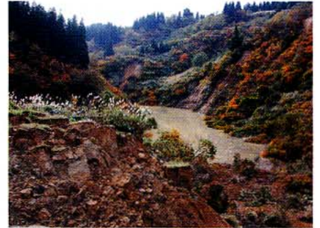
写真7 天然ダムによる湛水
