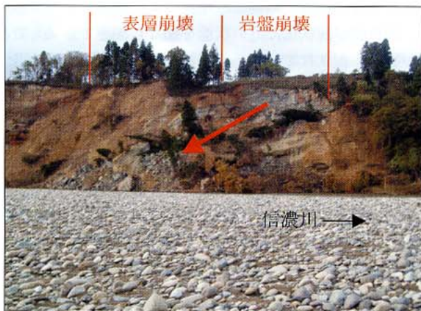
写真4 全景 (信濃川右岸より撮影)
